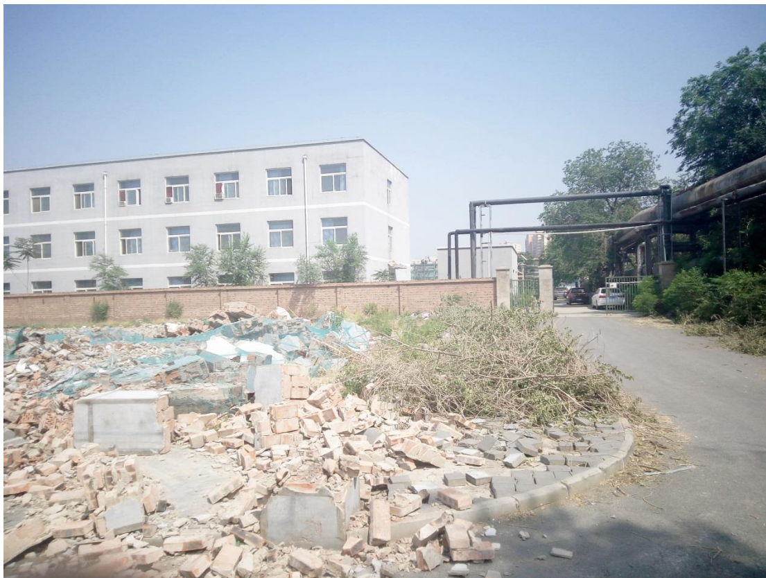
图 2.2-1 现场拆除垃圾及未拆除建筑管道
