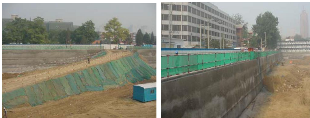
图 12.1-2 坡道防护和基坑临边防护
