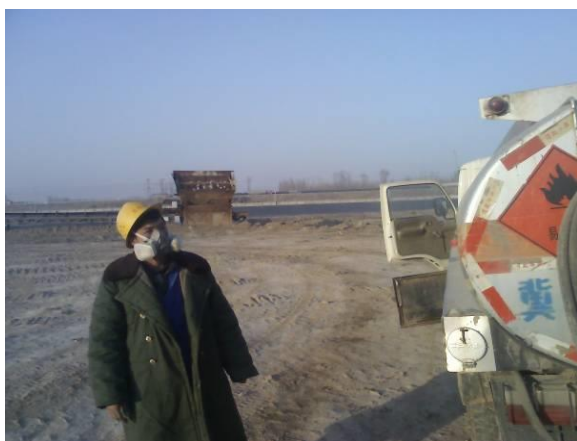
(1) 施工工人防护措施
