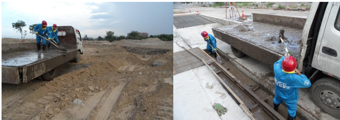
施工人员正清理洗车池泥浆
