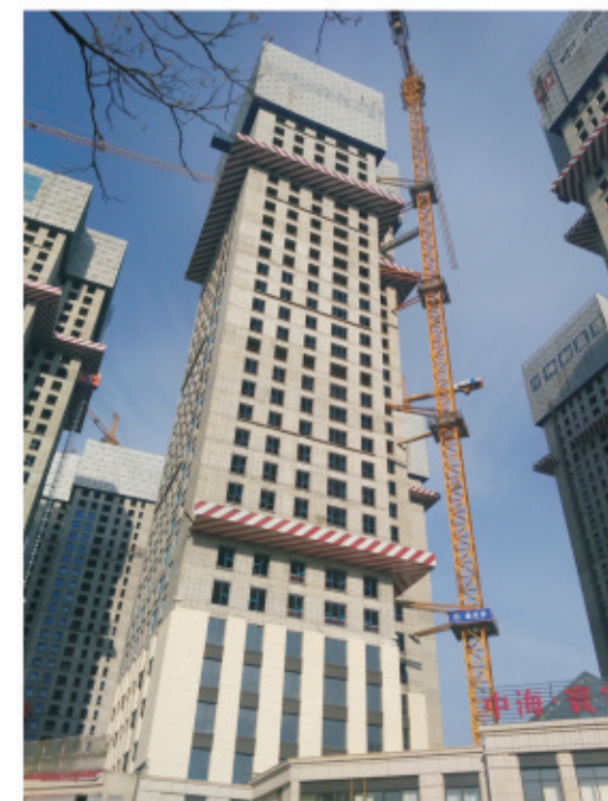
9#楼结构至37层，窗框安装至20层，本月底1-10层公区精装修开始施工
