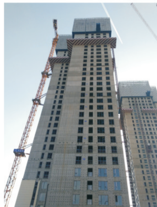
10#楼结构至36层，窗框安装至20层，本月底1-10层公区精装修开始施工
