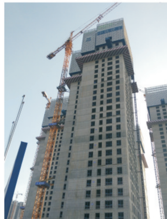
8#楼结构至36层，窗框安装至20层
