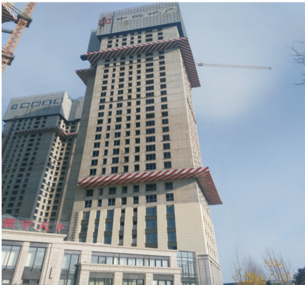
11#楼结构至37层，窗框安装至20层，本月底1-10层公区精装修开始施工
