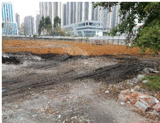
已拆除的锅炉车间区域
