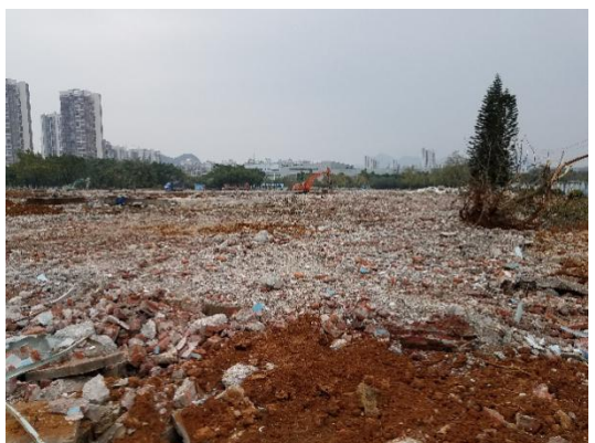
厂区设施拆除情况总貌
