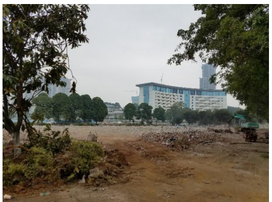
已拆除的淀粉仓库区域
