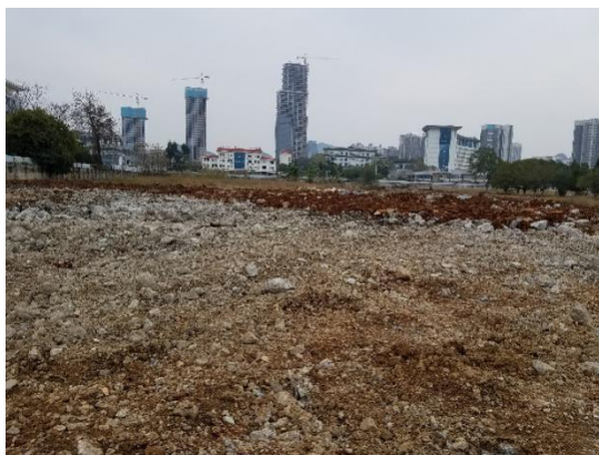
已拆除的污水处理站区域
