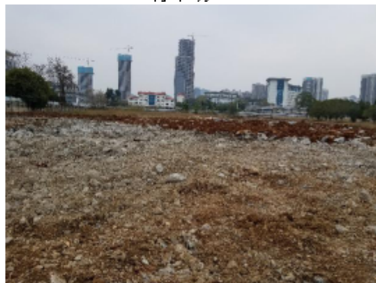
已拆除的污水处理站区域
