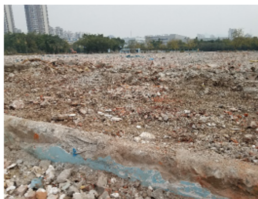
已拆除的生产车间区域
