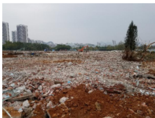
厂区设施拆除情况总貌
