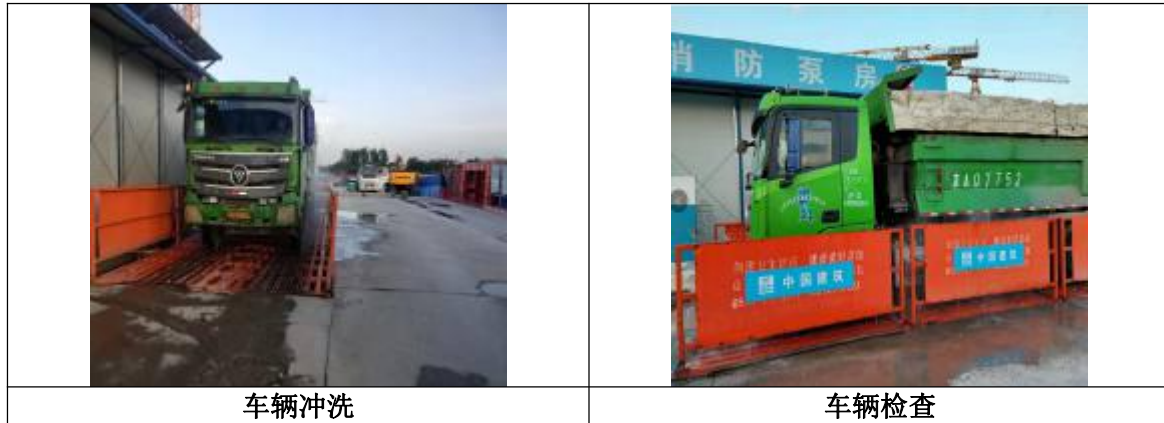
图 3.4-9 车辆冲洗和检查图
