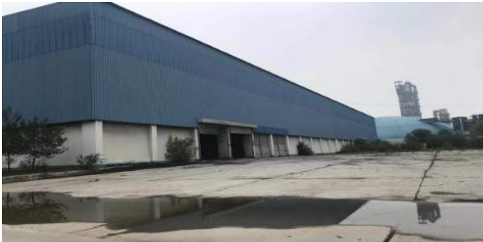
图 3.4-13 太行前景水泥有限公司密闭存储大棚
