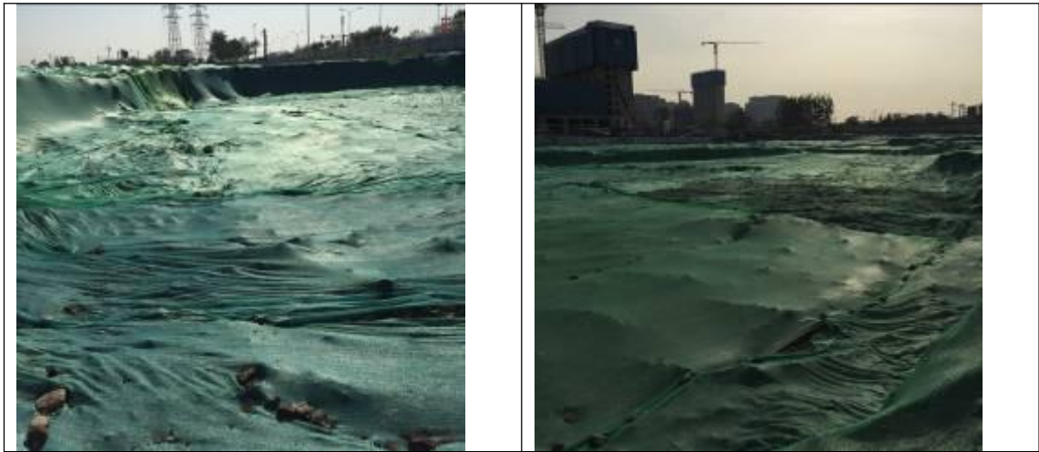
图 3.5-1 裸露土壤苫盖
