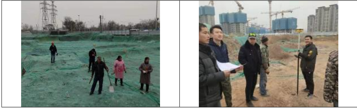
图 3.4-1 开工前的定位放线
