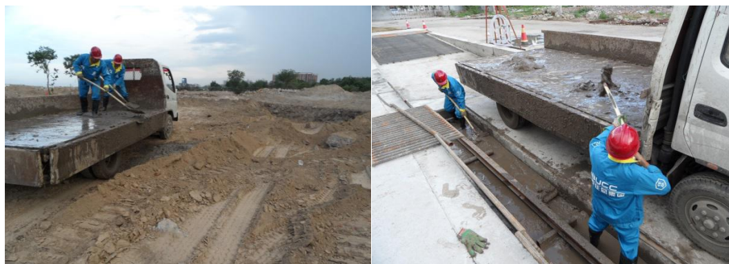
施工人员正清理洗车池泥浆
