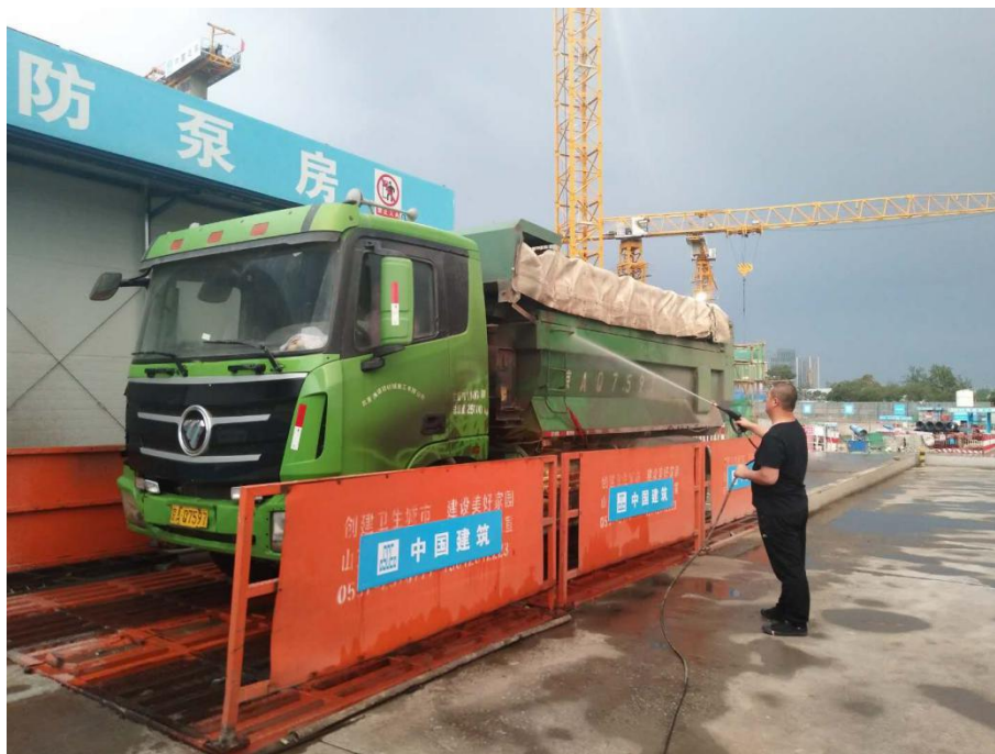
图 3.1-3 污染土壤运输洗车照片
