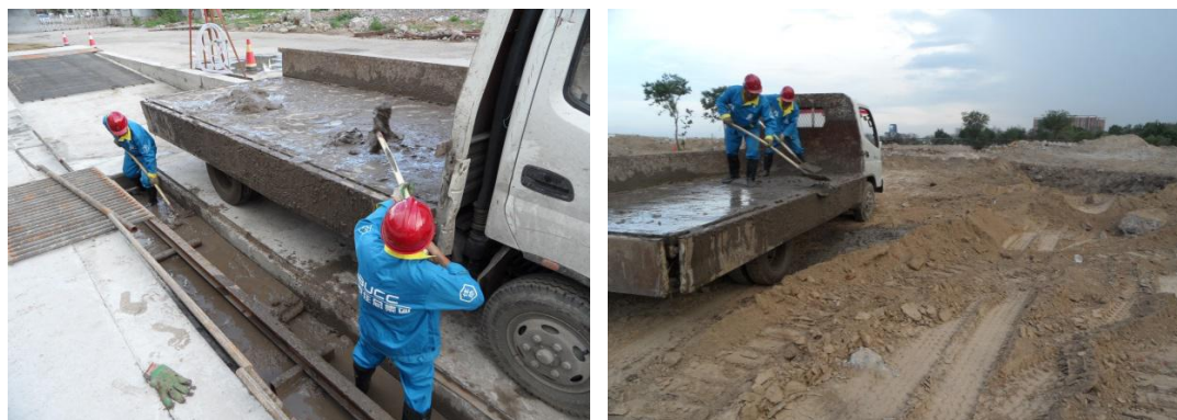
施工人员正清理洗车池泥浆
