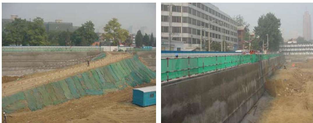
图 11.1-2 坡道防护和基坑临边防护
