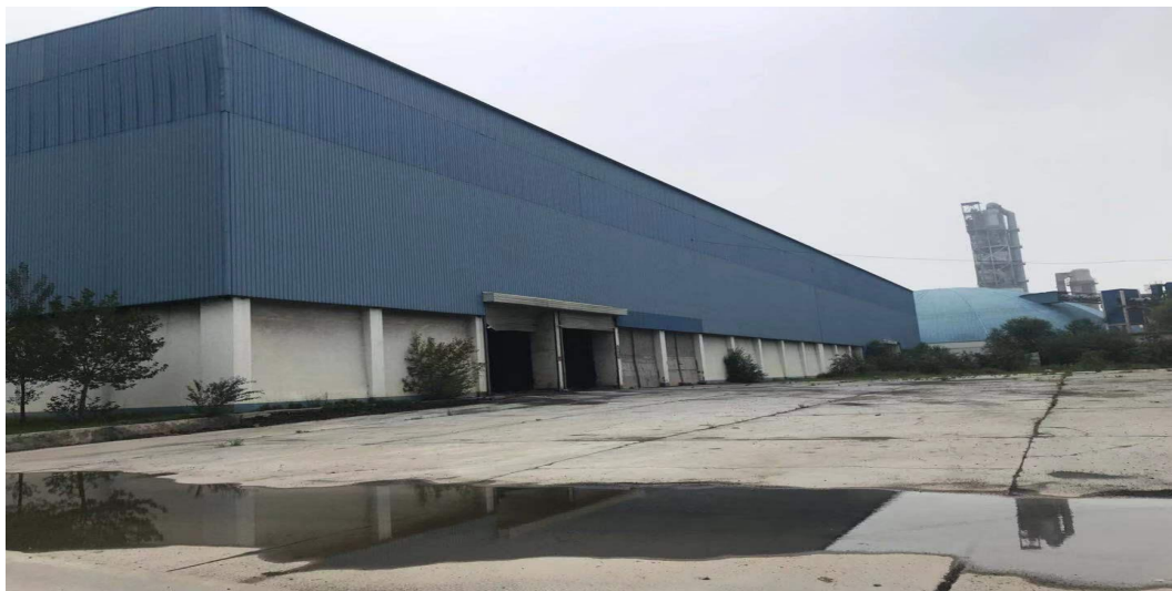
图 5.2-3 前景公司大棚储存库
