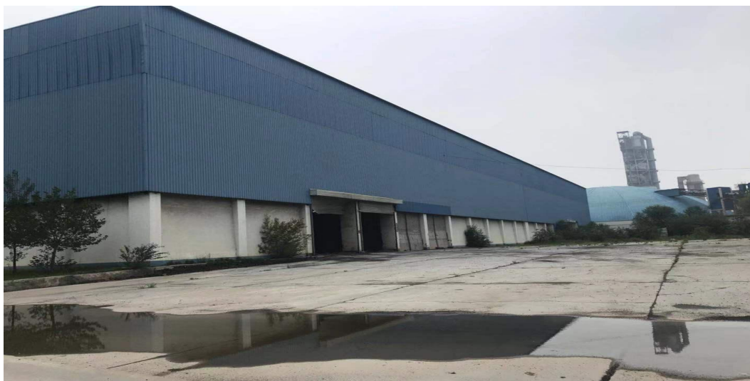
图 5.2-4 前景公司大棚储存库
