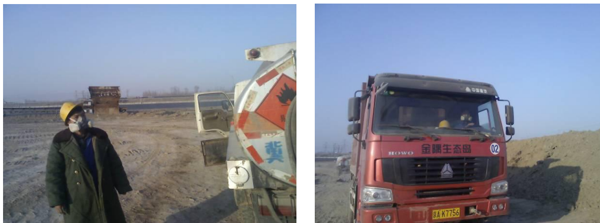
图 9.3-1 施工时基本防护情况图
