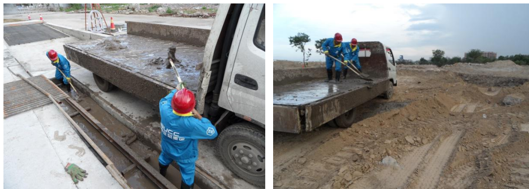
施工人员正清理洗车池泥浆
