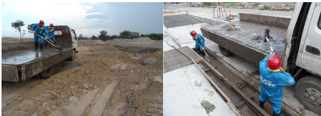
施工人员正清清洗车池泥浆
