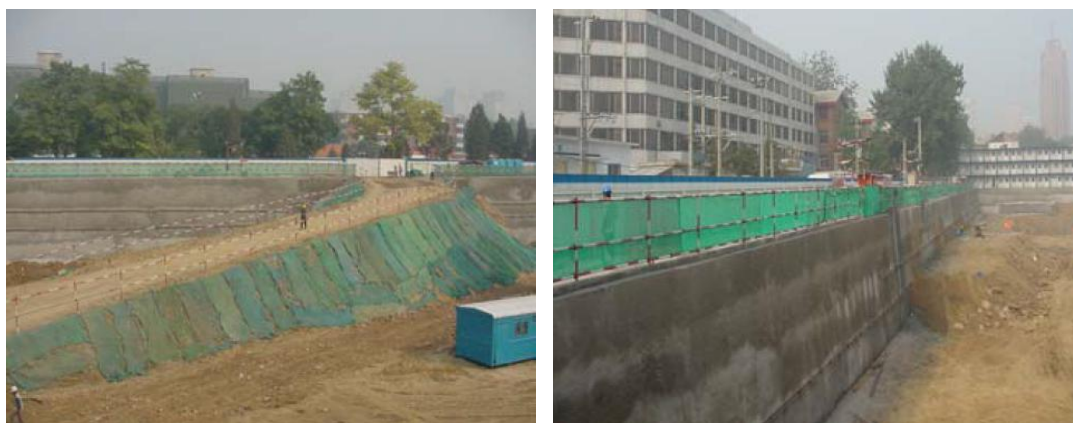
图 11.1-2 坡道防护和基坑临边防护
