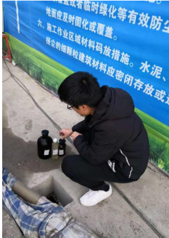
图 6.2-3 清挖施工现场废水采样图
