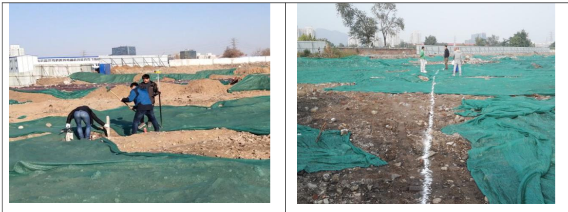
图 5.1-1 现场测量放线
