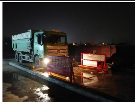
图 6.4-2 洗车池冲洗轮胎
