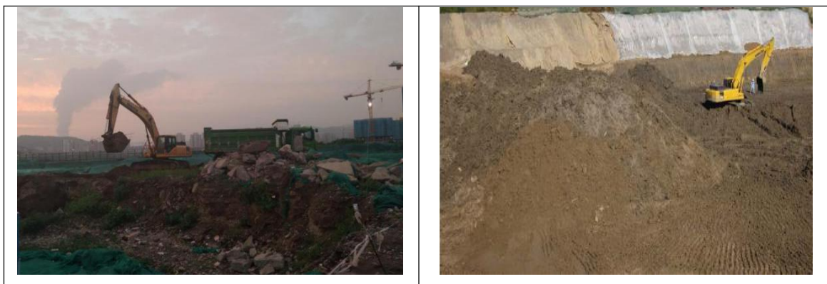
图 5.2-5 污染土壤清挖
