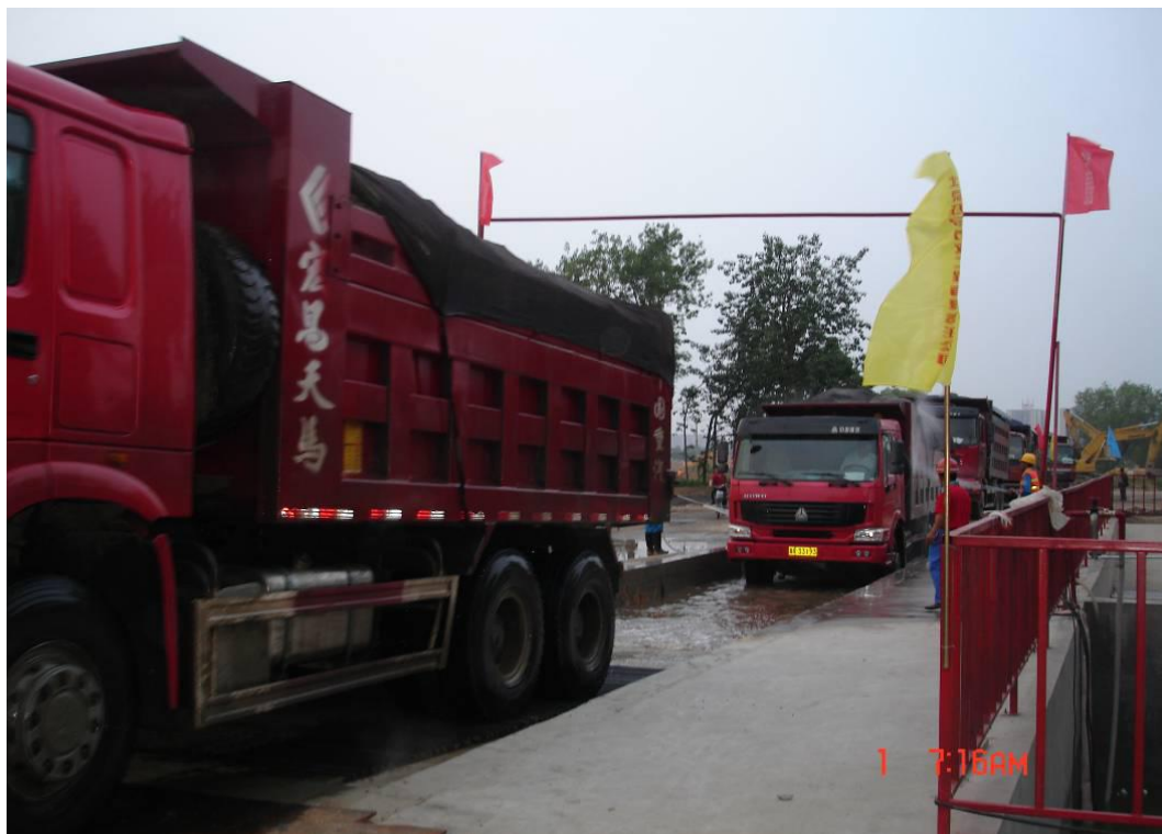
图 3.1-3 污染土壤运输洗车照片
