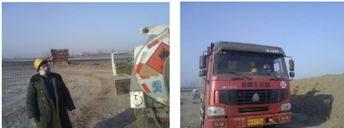
图 9.3-1 施工时基本防护情况图
