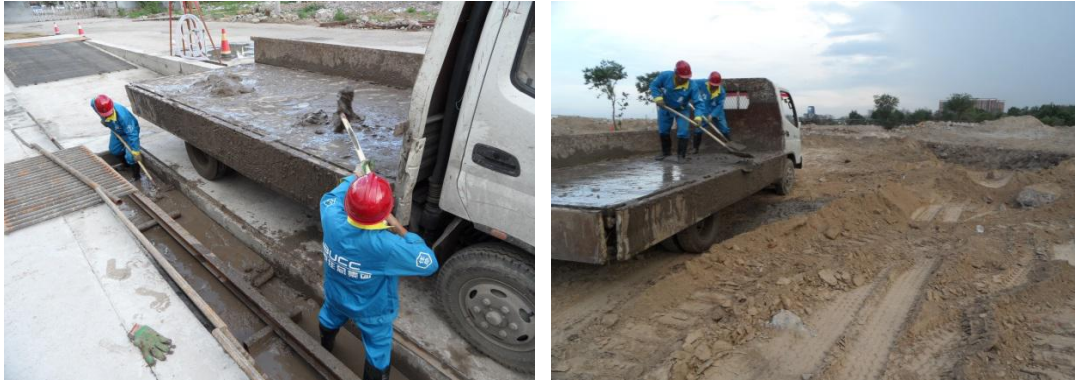
施工人员正清理洗车池泥浆
