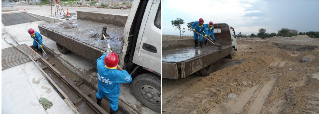
施工人员正清理洗车池泥浆
