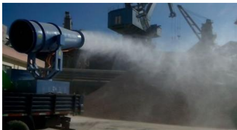
图 5.6-1 施工过程中雾炮设备
