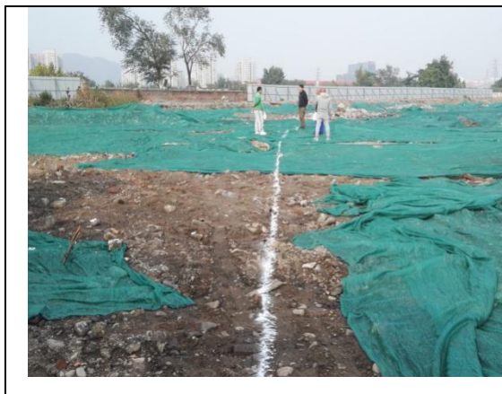
图 5.1-1 现场测量放线图
