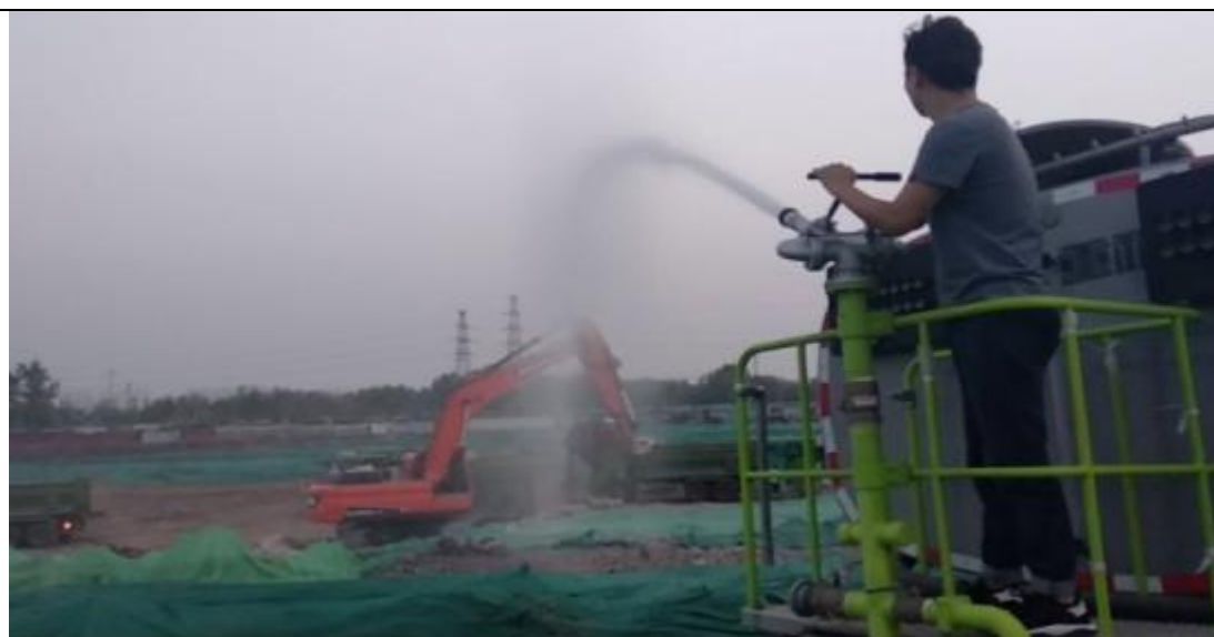
图 5.6-3 施工过程中喷雾除尘
