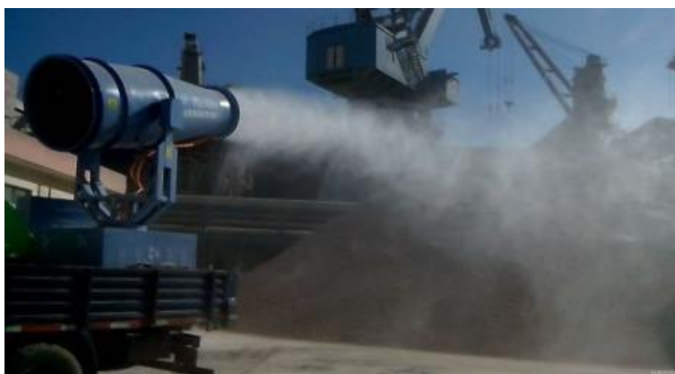
图 6.1-1 施工过程中雾炮设备
