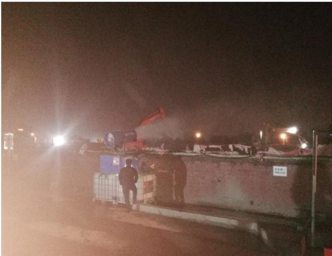
图 6.1-1 施工过程中雾炮设备
