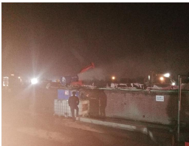
图 5.6-1 施工过程中雾炮设备
