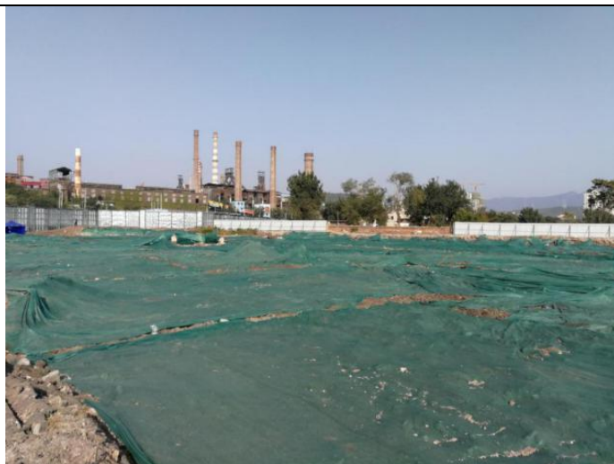
图 5.6-2 清挖基坑防尘覆盖
