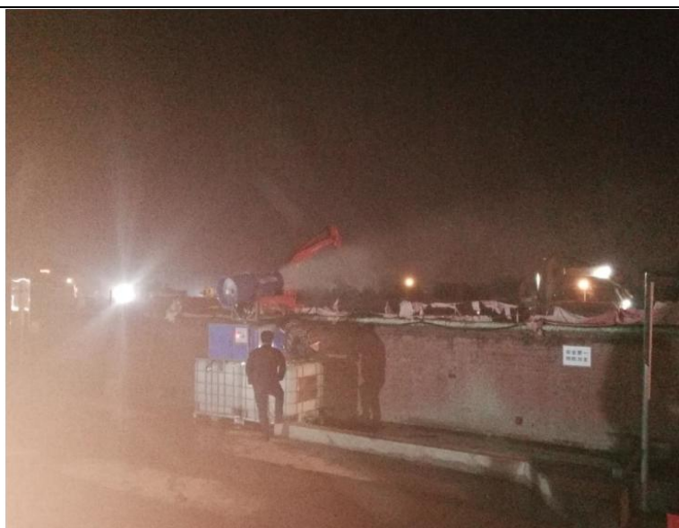
图 5.6-3 施工过程中喷雾除尘
