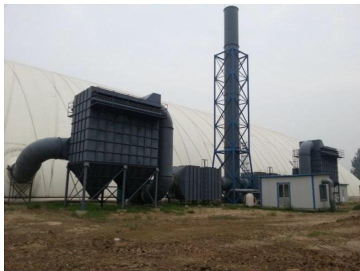
图 4-5 污染气体净化系统装置图
