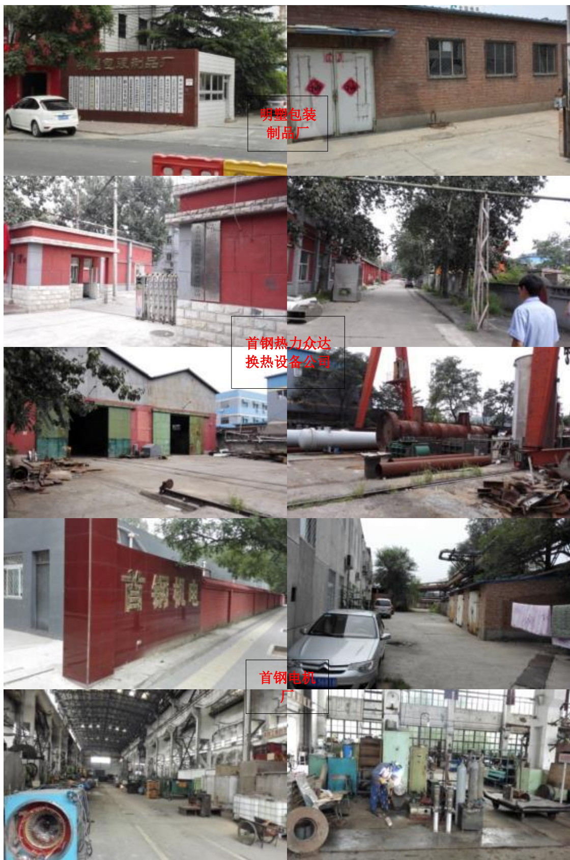
图 2.1-12 调查区域内部分厂房现存状况
