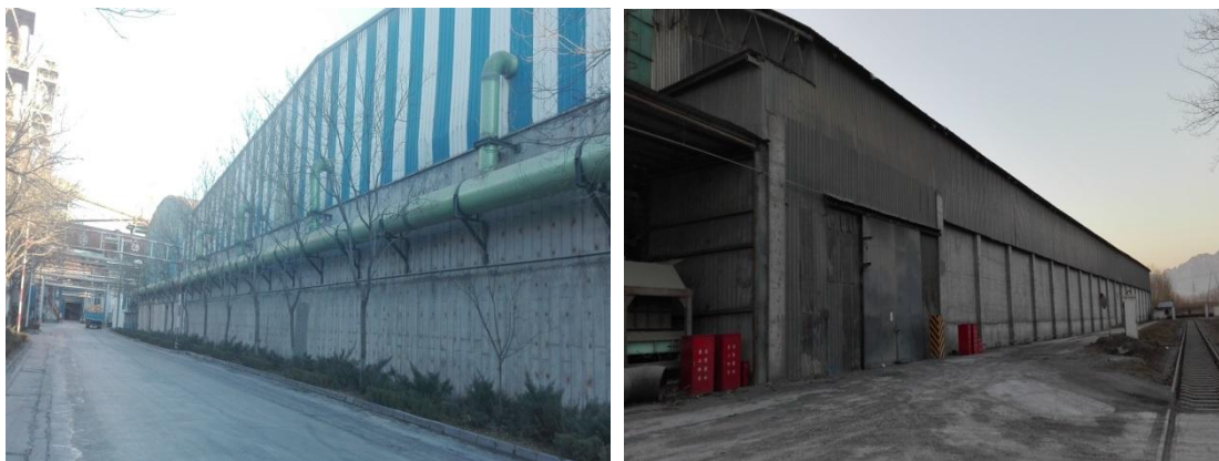
图 2.1-4 全封闭式微负压大棚
