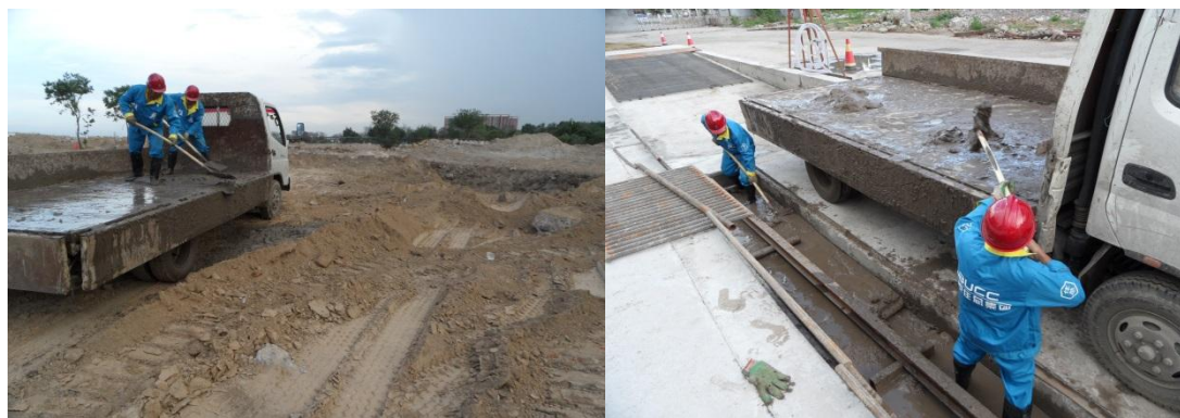
施工人员正清理洗车池泥浆
