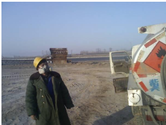
(1) 施工工人防护措施
