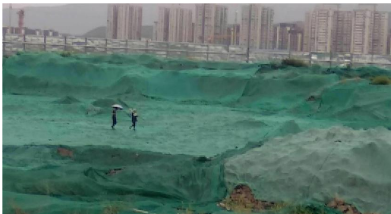
图 2.1-1 施工现场防尘网苫盖
