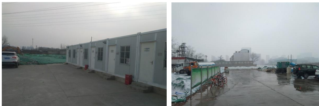
图 3.3-2 项目办公区、施工材料存放区
