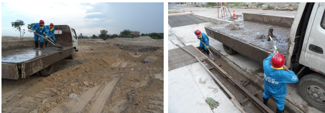
施工人员正清理洗车池泥浆
