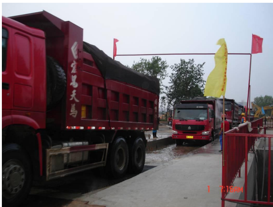
图 3.1-3 其它污染土治理项目中的污染土壤运输洗车照片
