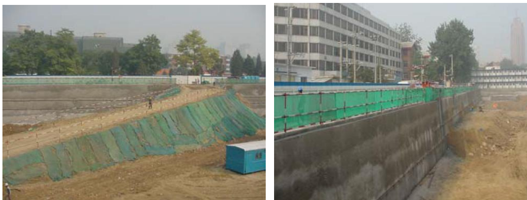
图 11.1-2 坡道防护和基坑临边防护
