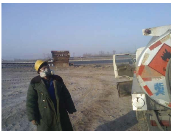
（1）施工工人防护措施
