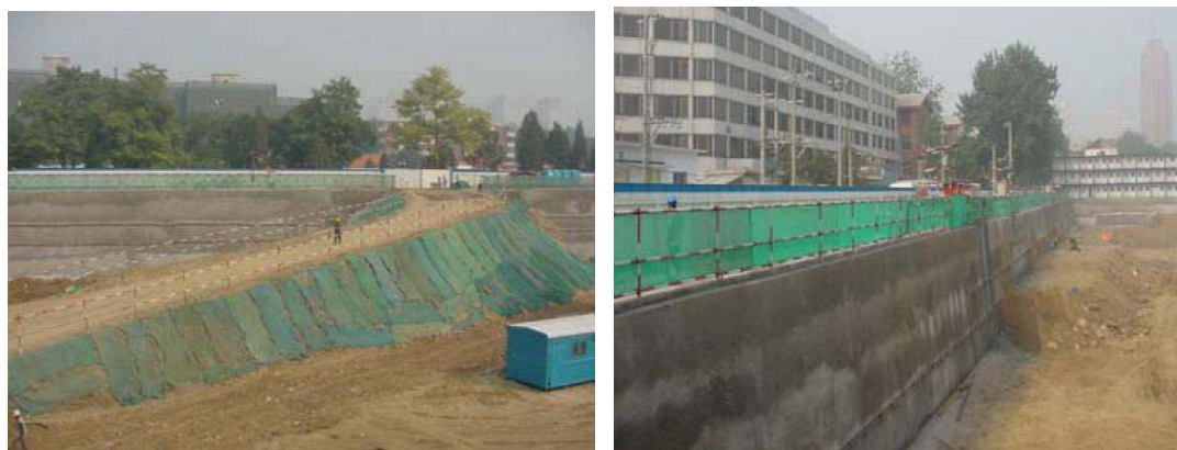
图 12.1-2 坡道防护和基坑临边防护
