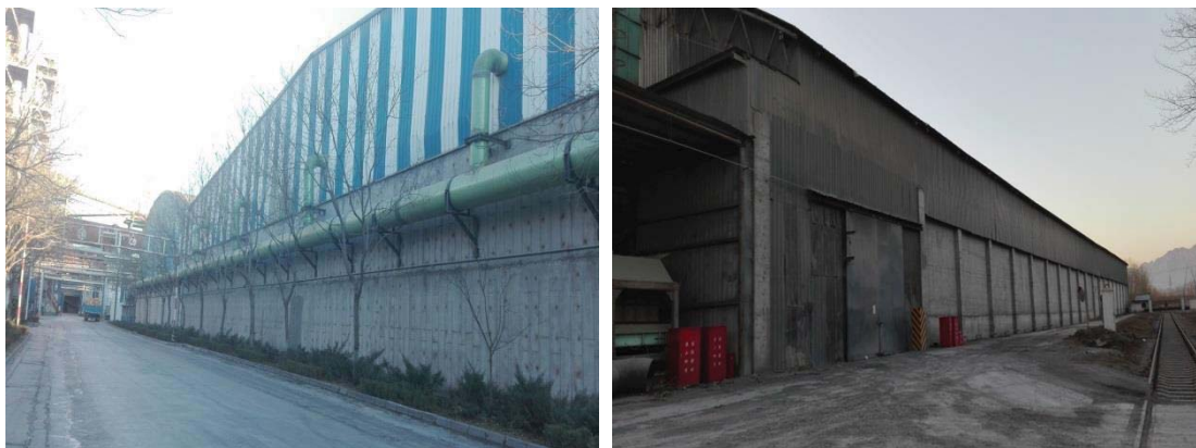
图 2.1-4 全封闭式负压大棚
