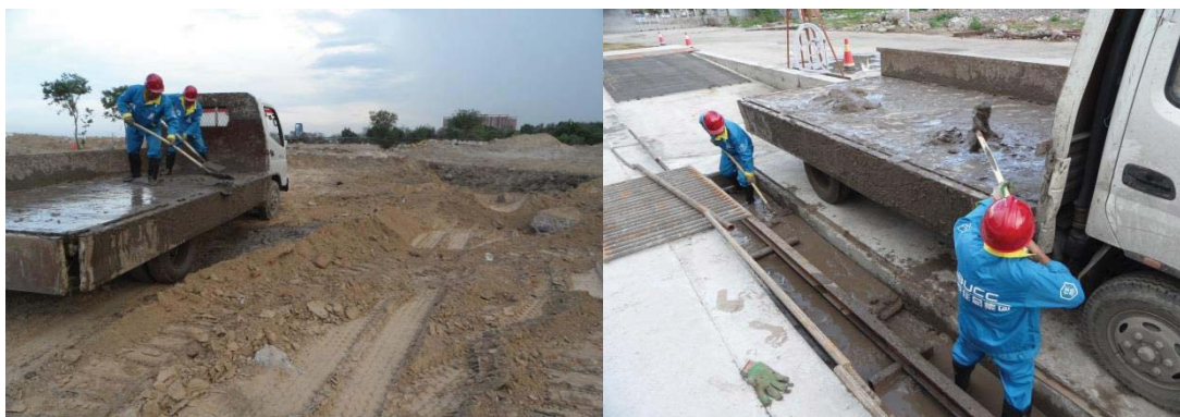
施工人员正清理洗车池泥浆
