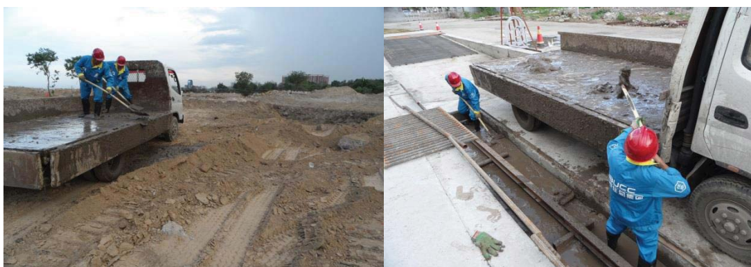
施工人员正清理洗车池泥浆
