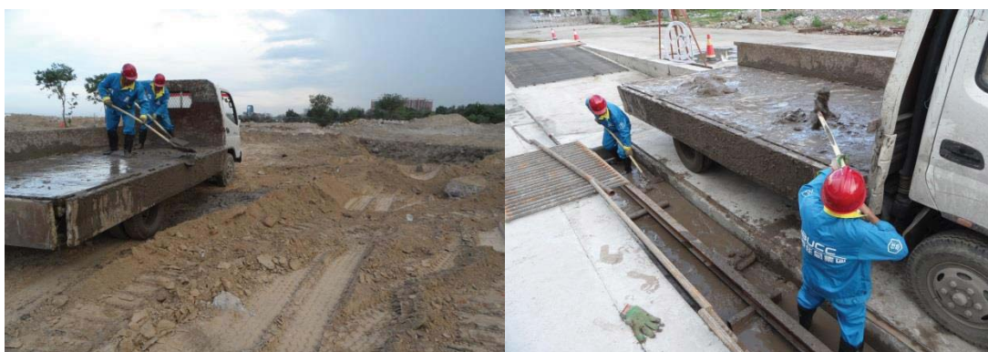
施工人员正清理洗车池泥浆
