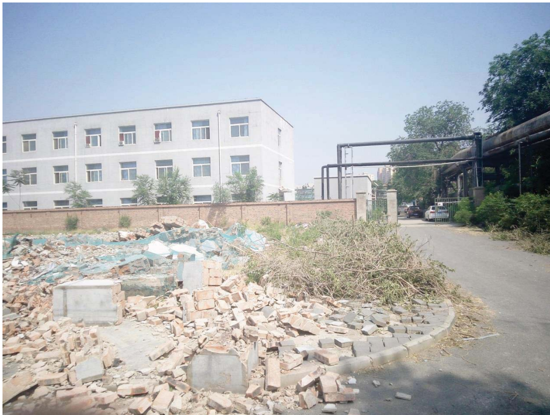
图 2.2-1 现场拆除垃圾及未拆除建筑管道
