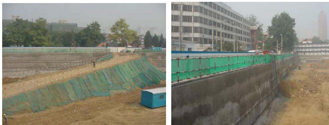
图 12.1-2 坡道防护和基坑临边防护
