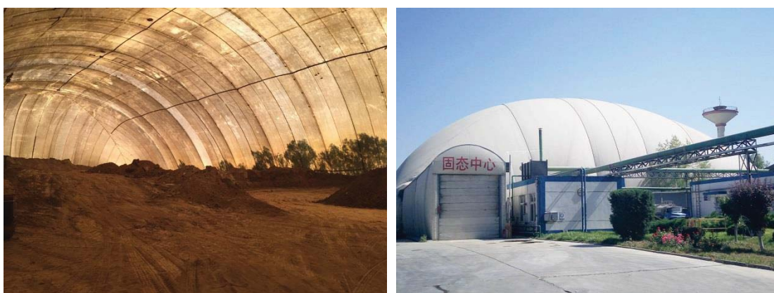
图 2.1-5 全封闭膜结构大棚
