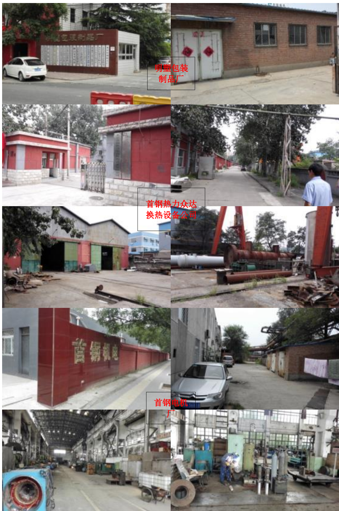
图 2.1-12 调查区域内部分厂房现存状况
