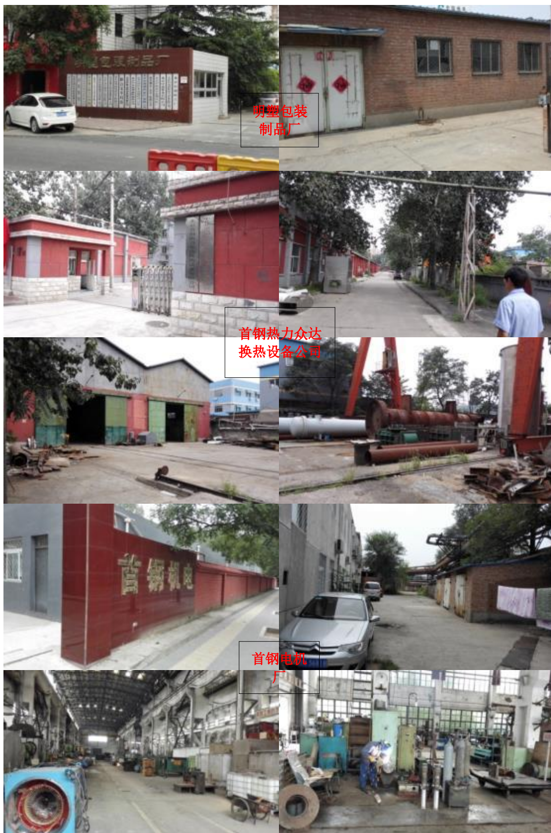
图 2.1-12 调查区域内部分厂房现存状况
