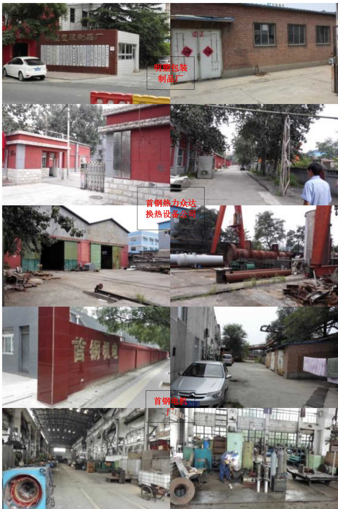
图 2.1-12 调查区域内部分厂房现存状况
