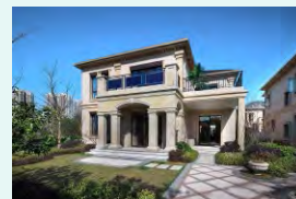
► 科技示範區低層住宅
